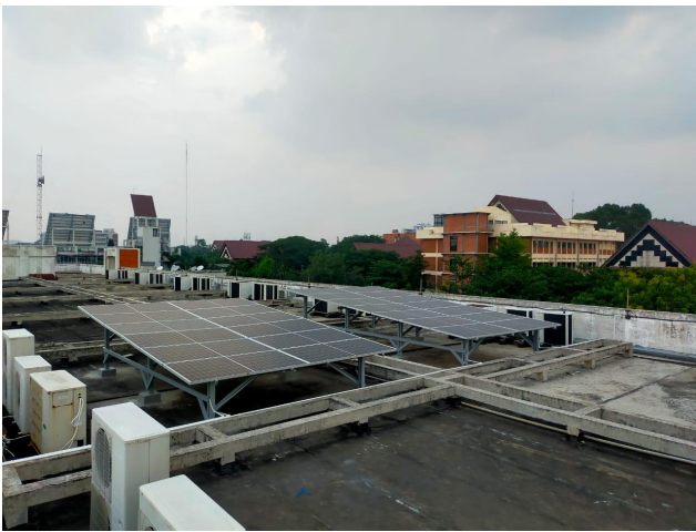
Solar panel dengan total 10 kWp di FEB UI
