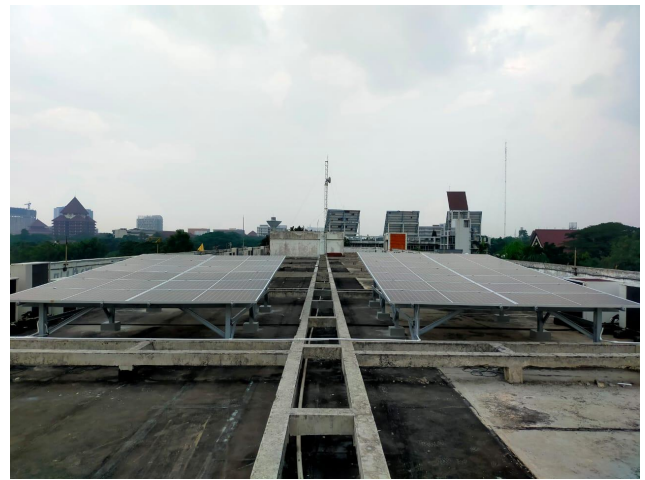
Solar panel dengan total 10 kWp di FEB UI
