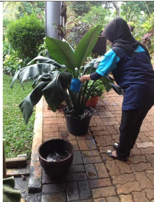
Pemanfaatan Air Kondensasi AC untuk Penyiraman Tanaman
