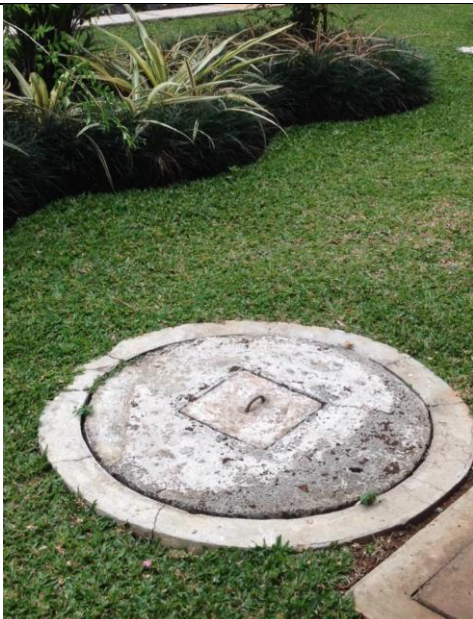
Sumur Resapan di Gedung Pascasarjana
