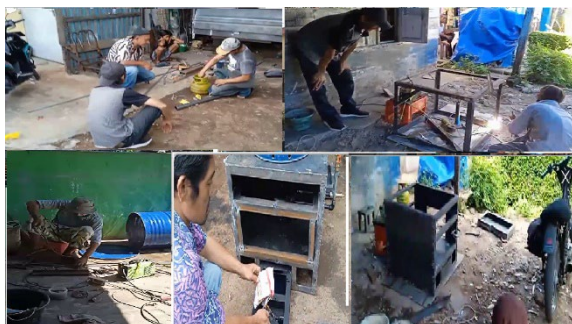
Gambar 5. Proses Pembuatan Alat di Lokasi Sumber: dok pribadi, Juni 2024
